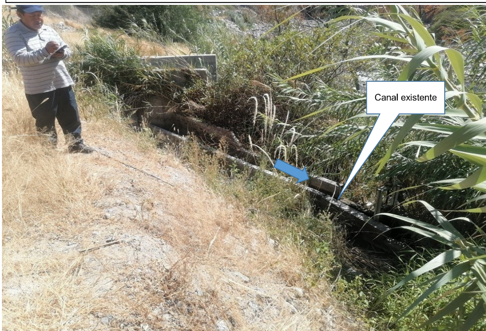
FIGURA N°03: TRAMO CRÍTICO, VISTA AGUAS ARRIBA DEL PUNTO FINAL, MATERIAL COLMATADO
